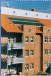
Zonne-installatie appartementencomplex Emmertal
